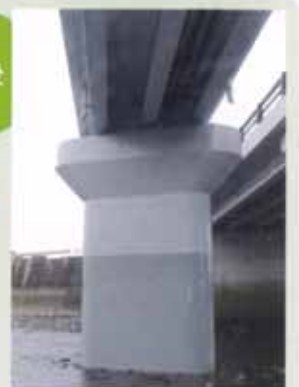
佐賀県太良町新糸岐歩道橋
