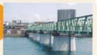
熊本県八代市前川橋
