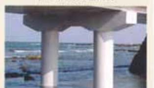
宮崎県青島弥生橋
